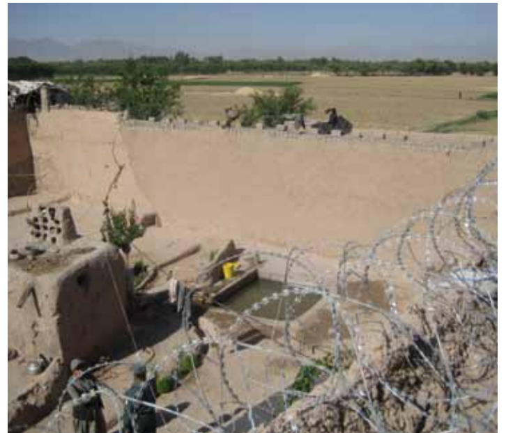
De gevangenis van Tarin Kowt met de inmiddels weer gerepareerde muur.
